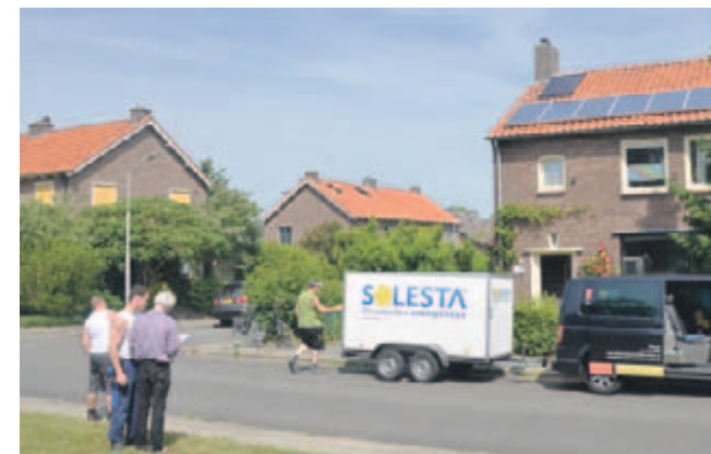
De zonneboiler wordt geïnstalleerd op het dak van de familie Van Dokkum.
